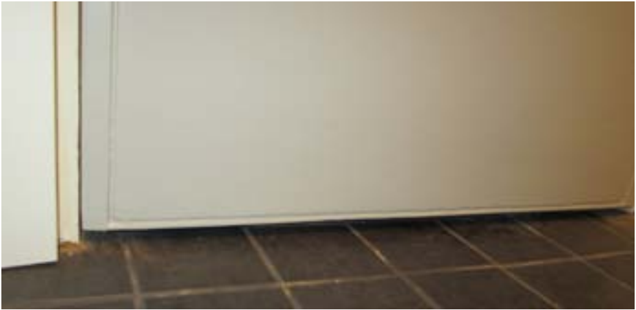
Kuva 8. Kuvassa WC oven kynnyksrako. Kuva Ketola.
