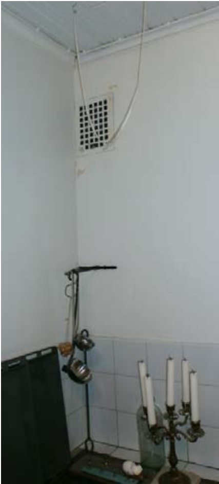
Kuva 5. Keittiön poistoilmäsäleikkö. Kuva: Ketola
