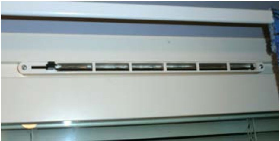
Kuva 12. Kuvassa ns. karmiventtiili. Kuva: Ketola
